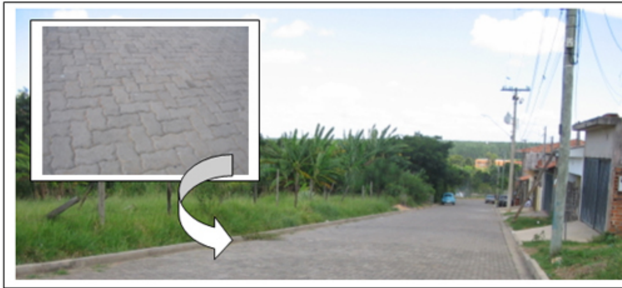
Pavimentação com pisos intertravados (bloquetes) Residencial Santa Angelina - São Carlos - SP
